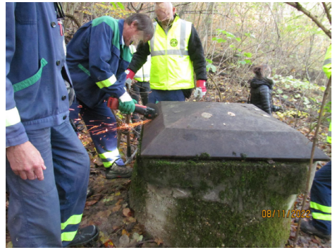
A Disznófő forrás feletti forrásvízgyűjtő galéria ellenőrző akájának felnyitási művelete. (2022)
