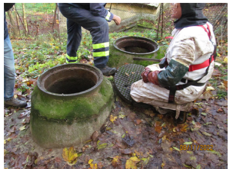
Disznófő forrásház melletti ellenőrző aknák a jobb oldali aknából tudna eljutni a forrásvíz a Vadkan fej kifolyóba. (2022)
