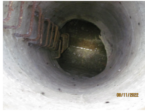
A forrásház feletti galéria az ellenőrző aknából a galériában kevés víz látható. (2022)
