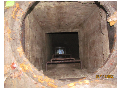
I_sz_Gyűjtőkút a Disznófő forrásház felett a Tündérhegyi út alatt innen is kap vizet a Disznófő forrás. (2022)
