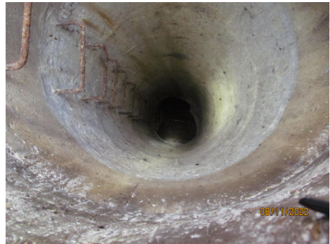
A forrásvíz gyűjtő galériába, forrásfoglalásba vezető ellenőrző akna belseje. (2022)
