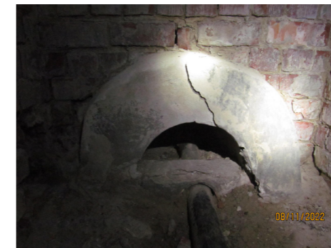
Lezárt kibetonozott forrásfoglalás alagút a foglalásfoglalás alagút első 5 métere után. (2022)
