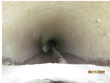
Disznófő forrás forrásalagútja kiberonozott csővel és pvc csővel. (2022)
