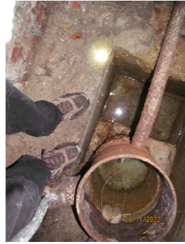
A forrásfoglalás galériából és az I Gyűjtőkútból érkező forrásvíz összefolyása a forrásfoglalásban. (2022)
