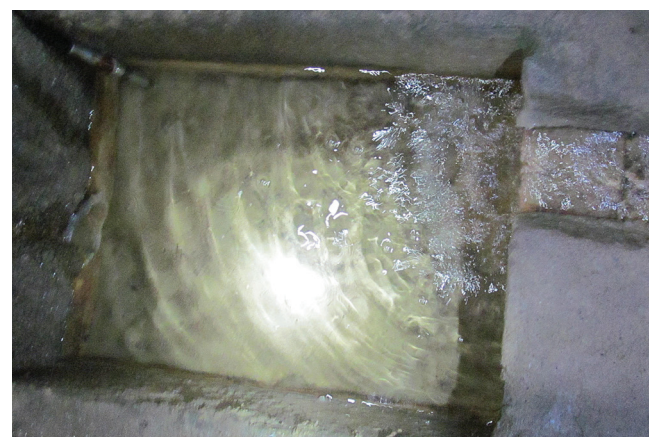
17. kép: A Városkút-forrás közvetlenül a csatornába ömlő 23–47 m 3 /nap hideg forrásvíze
