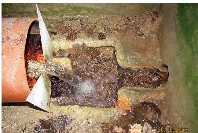
16. kép: A Béla király kút forrás közvetlenül a csatornába ömlő 36–82 m 3 /nap hideg forrásvíze
